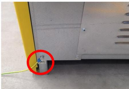
Figura 35 – Collegamento equipotenziale
