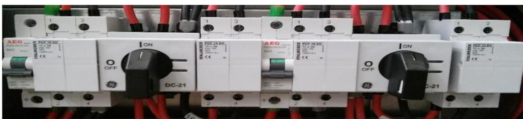
Figura 63 – Posizione protezioni quadro elettrico Ston per resettare gli allarmi
