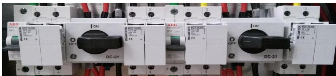
Figura 2 – Posizione protezioni quadro elettrico Ston prima delle operazioni di cablaggio
