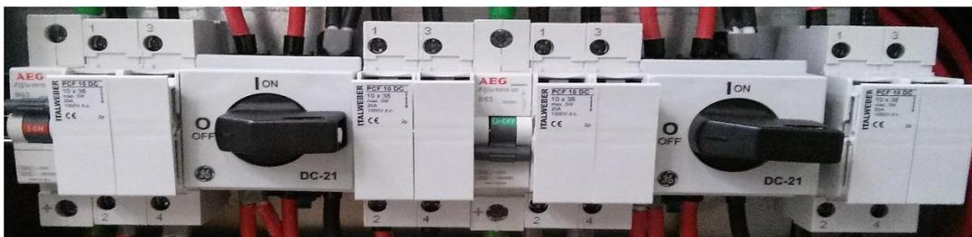
Figura 42 – Posizione protezioni quadro elettrico Ston per l’attivazione e la verifica
