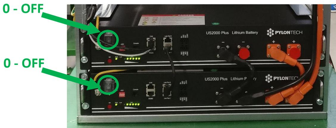
Figura 87 - Interruttori "0/1" moduli batteria: settare ad "1"
