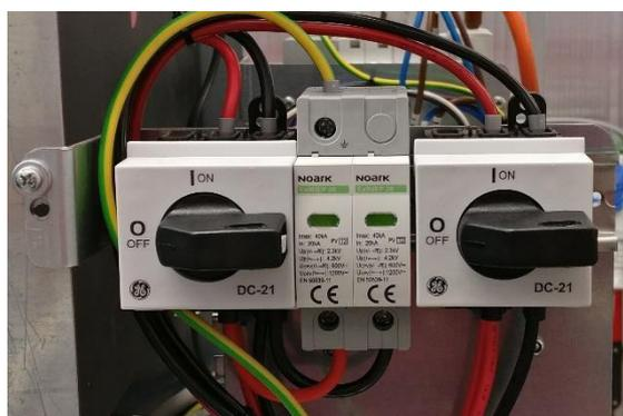
Figura 43 - Posizione di partenza protezioni quadro elettrico fianco sinistro RA.Store-Z
