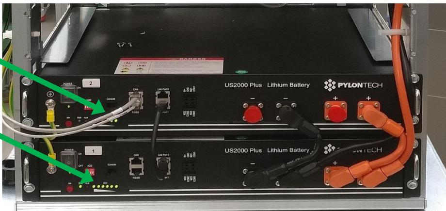
Figura 15 - Verificare accensione led moduli batteria
