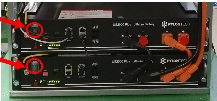
Figura 88 - Interruttori "0/1" moduli batteria: settare ad "1"
