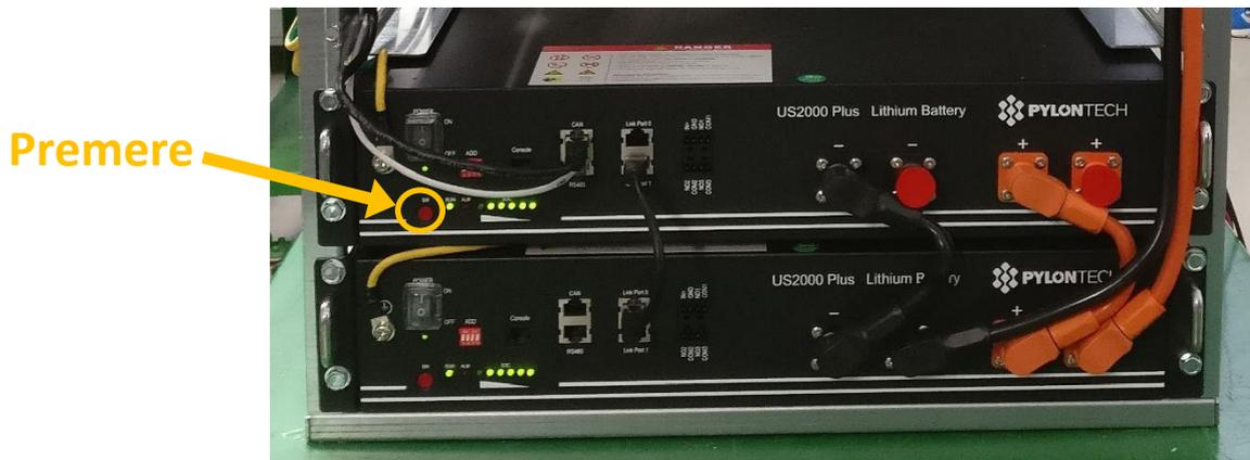
Figura 86 - Premere il pulsante rosso "SW" della batteria più in alto
