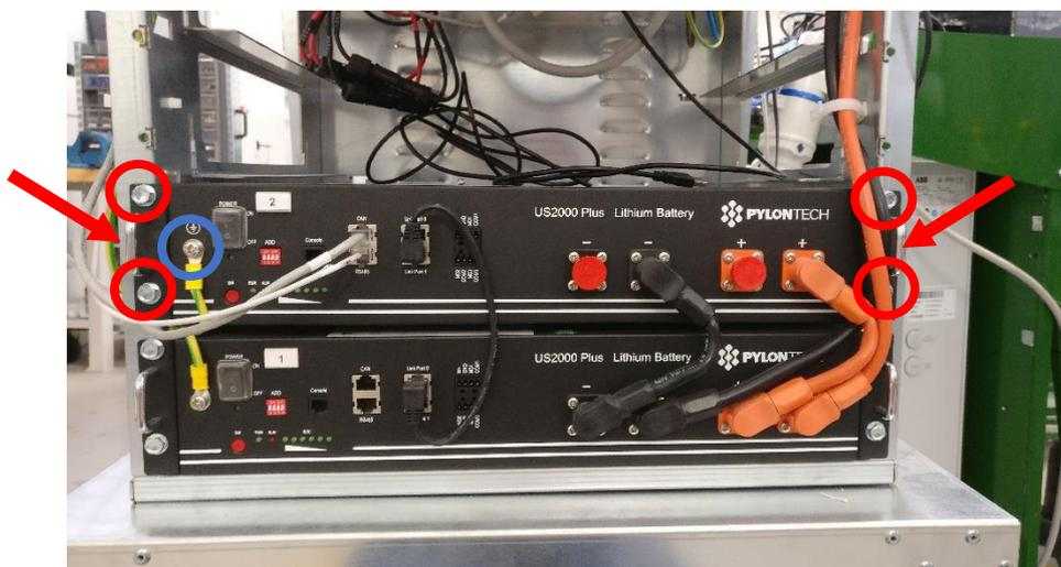
Figura 5 - Cablaggio moduli batteria
