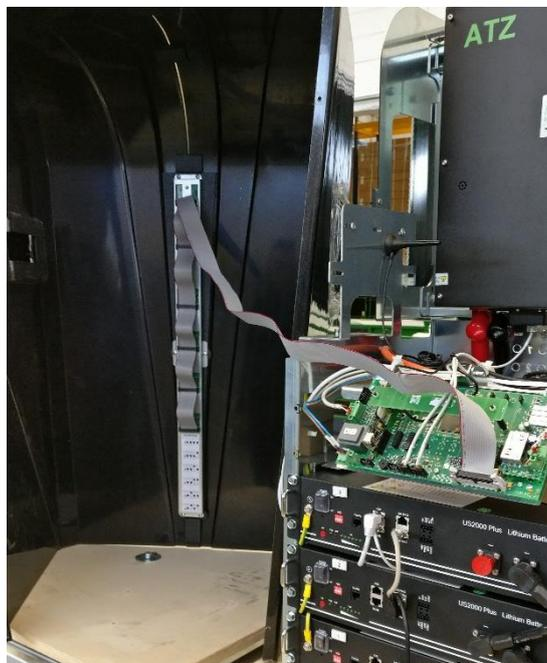
Figura 57 - Installazione del cavo indicatore LED
