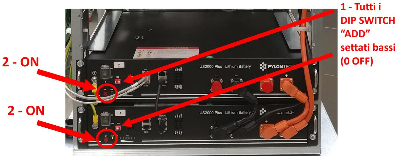
Figura 13 - Interruttori "0/1" moduli batteria: settare ad "1"
