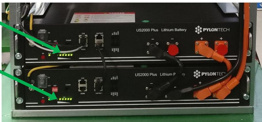
Figura 90 - Verificare accensione led moduli batteria
