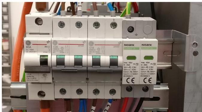
Figura 84 - Posizione di partenza protezioni quadro elettrico fianco destro RA.Store-Z
