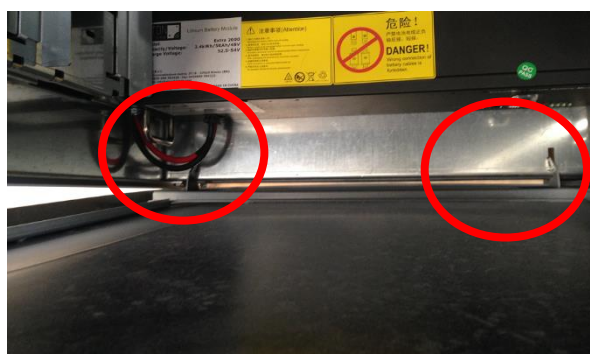
Figura 3 - Rimozione pannello frontale
