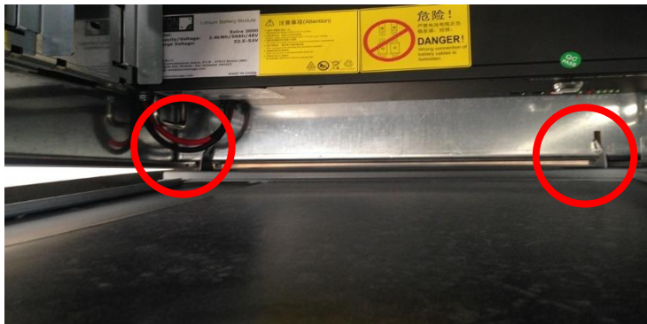
Figura 66 - Inserimento pannello nelle sedi inferiori
