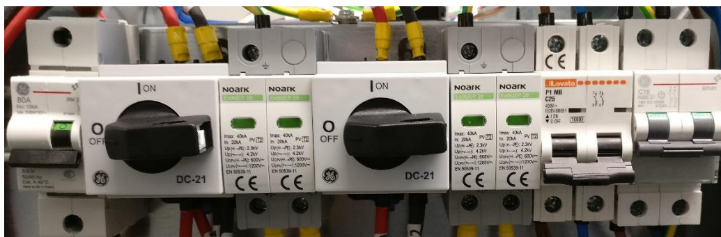
Figura 34 - Posizione di partenza protezioni quadro elettrico RA.Store-K-F
