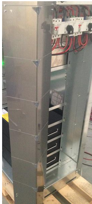
Figura 7 - Smontaggio angolo led
