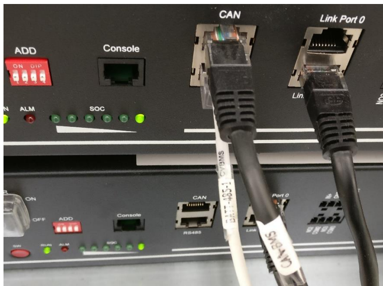
Figura 73 - Ripristino dei collegamenti: cavi segnali dati
