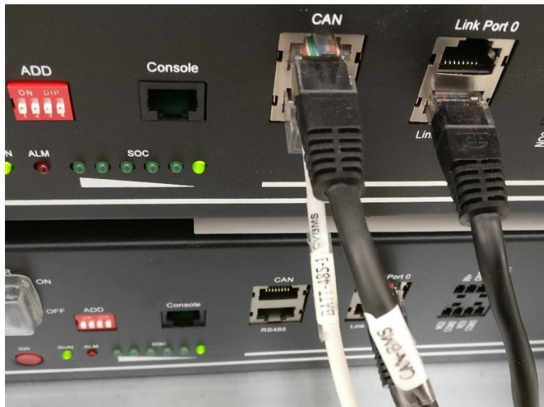
Figura 14 - Ripristino dei collegamenti: cavi segnali dati
