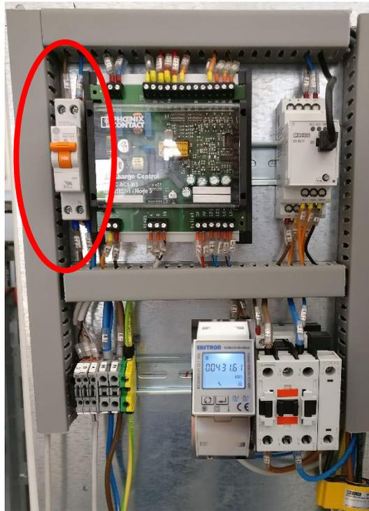
Figura 30 – Interruttore interno in posizione di ON
