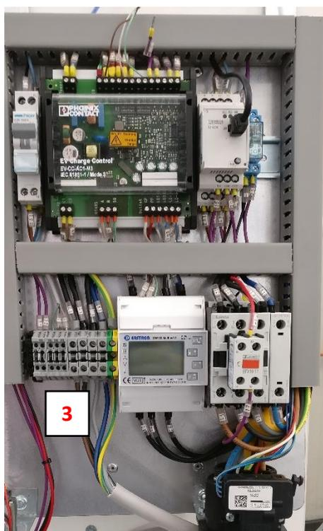
Figura 3 – Piastra posteriore (modello con alimentazione 3P+N+T)
