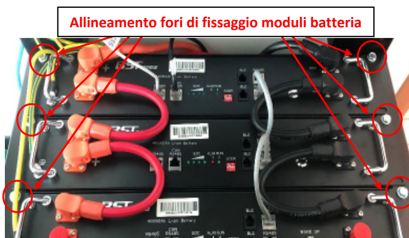
Figura 11 – Fissaggio Moduli al box batteria
