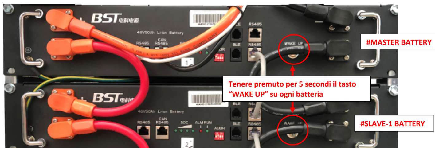
Figura 120 – Accensione/spegnimento batterie BST
