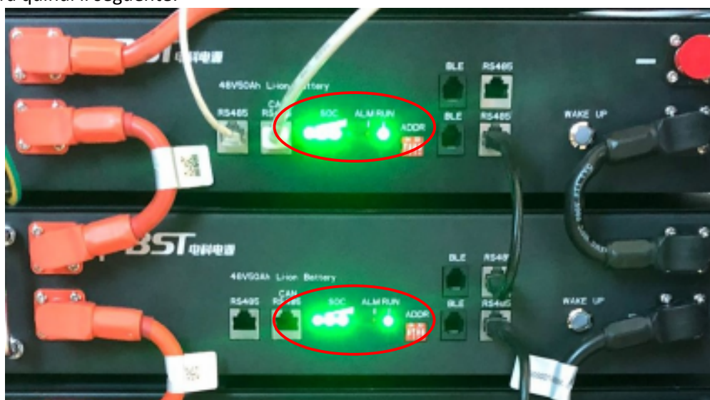
Figura 81 - Batteria BST accesa
