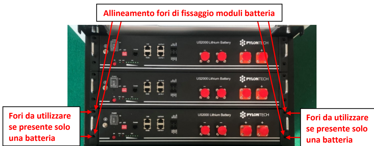
Figura 7 - Alloggiamento moduli batteria Pylontech (se previsti 3 moduli dalla dotazione)
