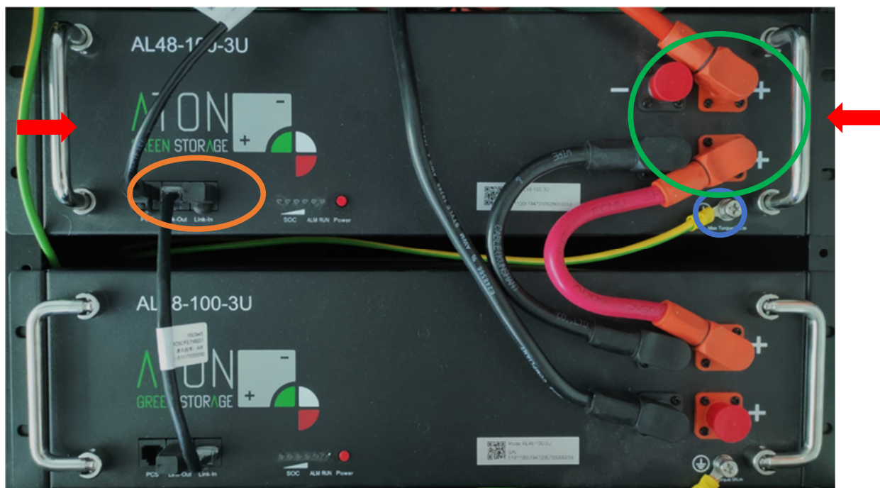
Figura 124 - Sostituzione modulo batteria ATON - Rimozione viti fissaggio modulo, vite collegamento equipotenziale, cablaggi di segnale e potenza.
