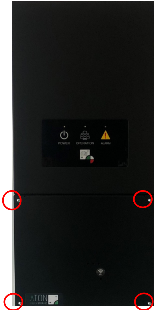
Figura 113 – Ripristino coperchio morsettiera ATH-BOX
