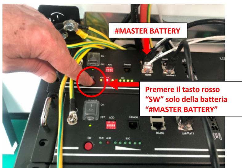
Figura 119 – Premere il tasto "SW" della batteria master per un secondo
