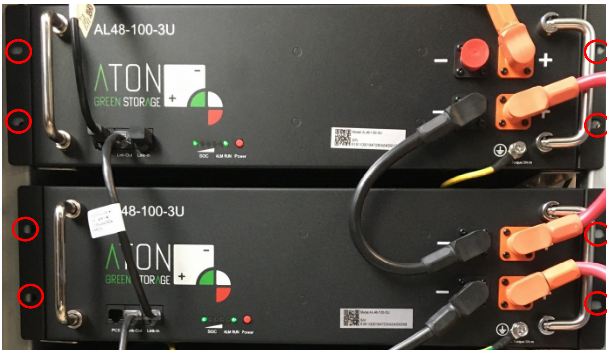
Figura 14 - Fori di fissaggio moduli batteria
