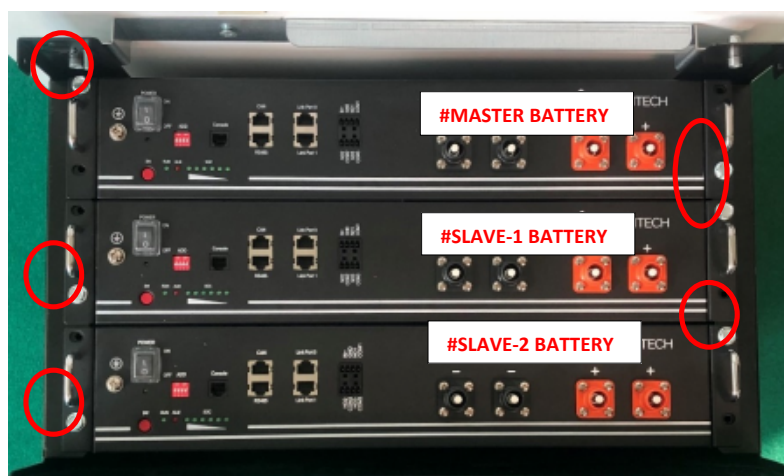
Figura 8 – Fissaggio moduli batteria al box batteria
